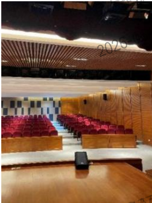
图 4-19 部分房间无排烟设施现状图
