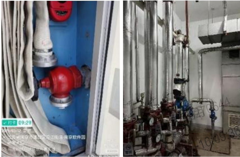
图 4-10 消火栓现状图
